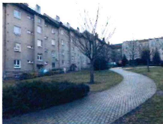
Pohled z vnitrobloku
