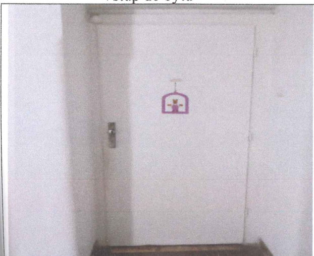
Vstup do bytu
