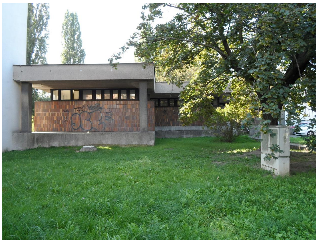
Pohled na pozemek p.č. 390/18 v k.ú. Černá Pole se stavbou č.p. 1755 (Bieblova č.or. 25)
